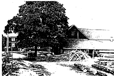
Sågverket vid gården, omkring 1930 flyttades såget till sin nuvarande plats
